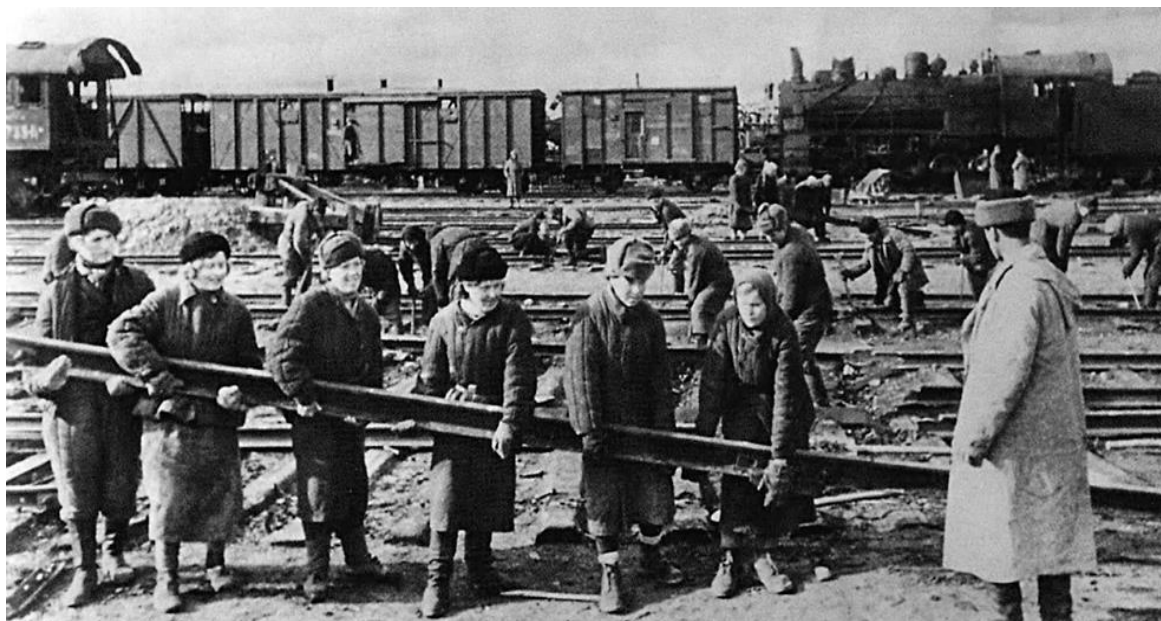
Восстановление железнодорожных путей на станции Ржев. Фото С. Тартаковского. 1943 г.
