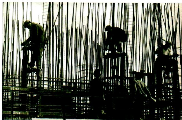
Кружевная арматура фундамента 2-й домны Запсиба.
