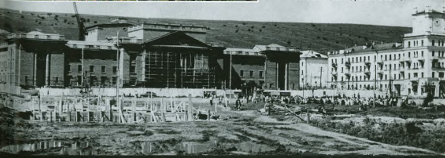
Строительство Дворца алюминщиков (фото 1955 г.)
